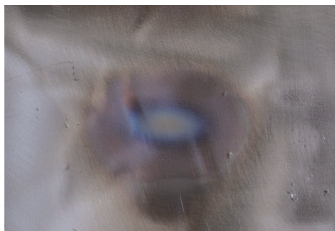
◀ Bild 5. Wenn auf Chromnickelstahl zu lange an Luftsauerstoff Temperaturen jenseits 300°C einwirken, wird in den oberen Schichten Chrom oxidiert, und es schillert blau und grau. Der Korrosionsschutz ist dahin.
