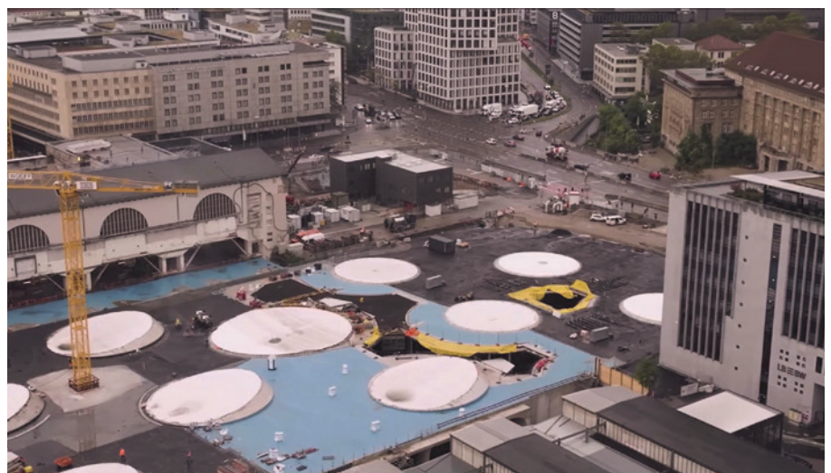
Bild 7: Auf dieser Drohnenaufnahme aus 2023 sind in der Betondecke die Öffnungen über den Kelch- stützen mit weißem Gewebe verspannt (aus dem „YouTube“-Video der Deutschen Bahn, siehe QR-Code) (© Deutsche Bahn)
