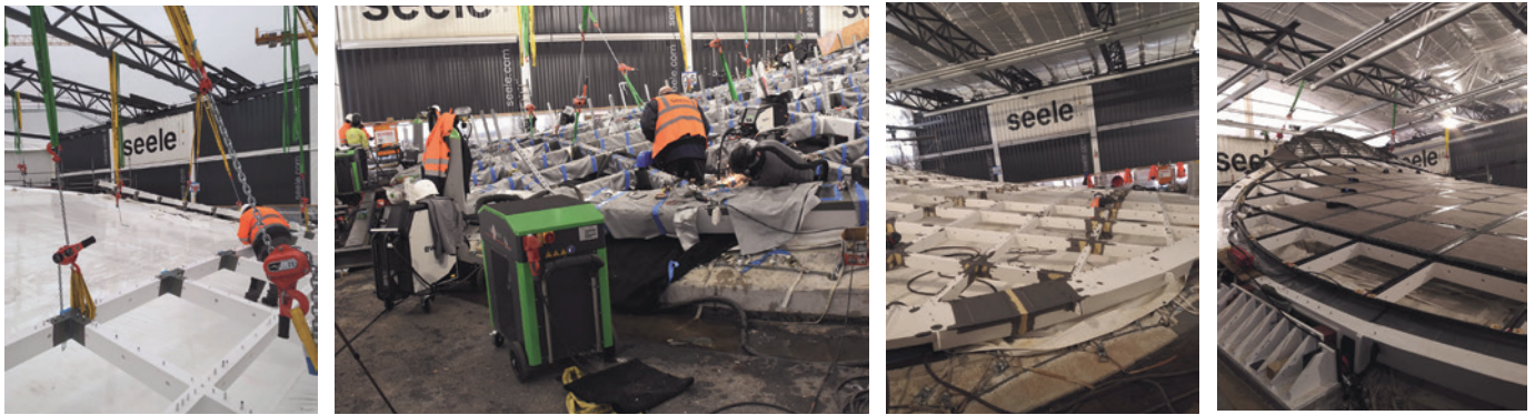
Bild 8: Links: Einheben der Segmente, dann Schweißarbeiten, Spachteln und Vervollständigen der Beschichtung; rechts: Montage der Glasscheiben und ihrer Metallrahmen (© VauQuadrat GmbH)
